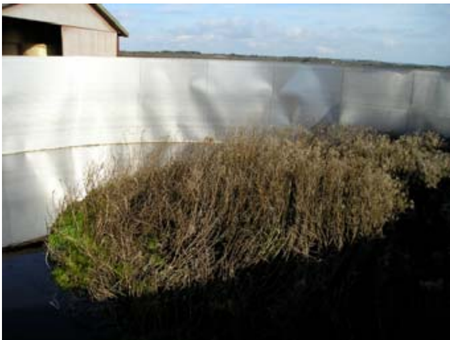
Figur 5.10 Samme beholder som i figur 9. Bulerne i væggen skyldes antagelig påvirkning udefra på tom beholder.
