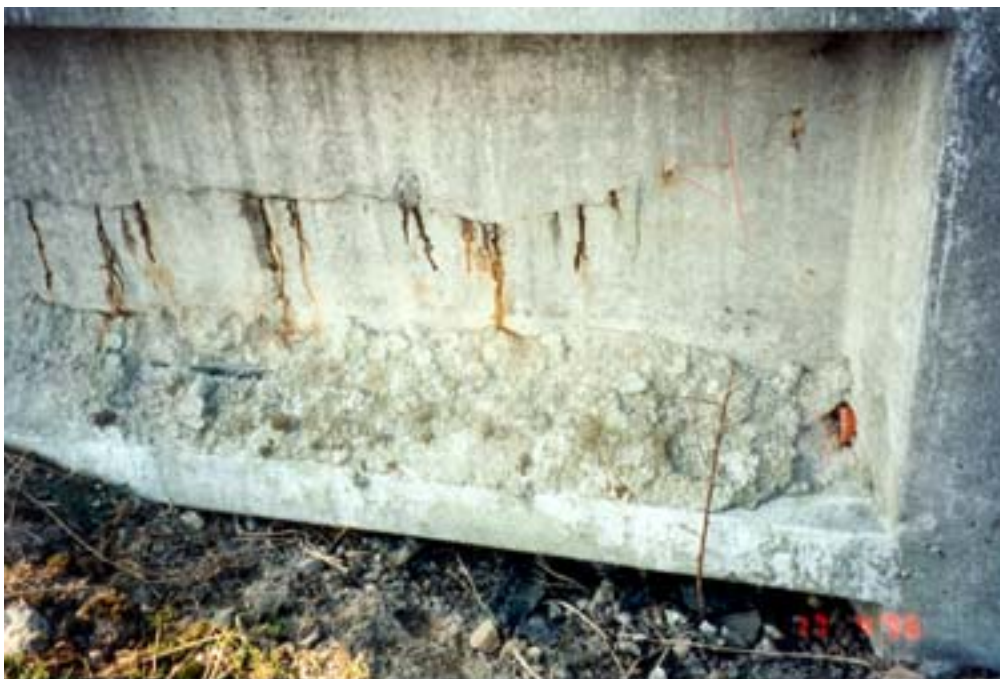
Figur 7.12 Hvis der siver gylle gennem revnen som her skal der ske en tætning og udbedring på beholderens inderside.
