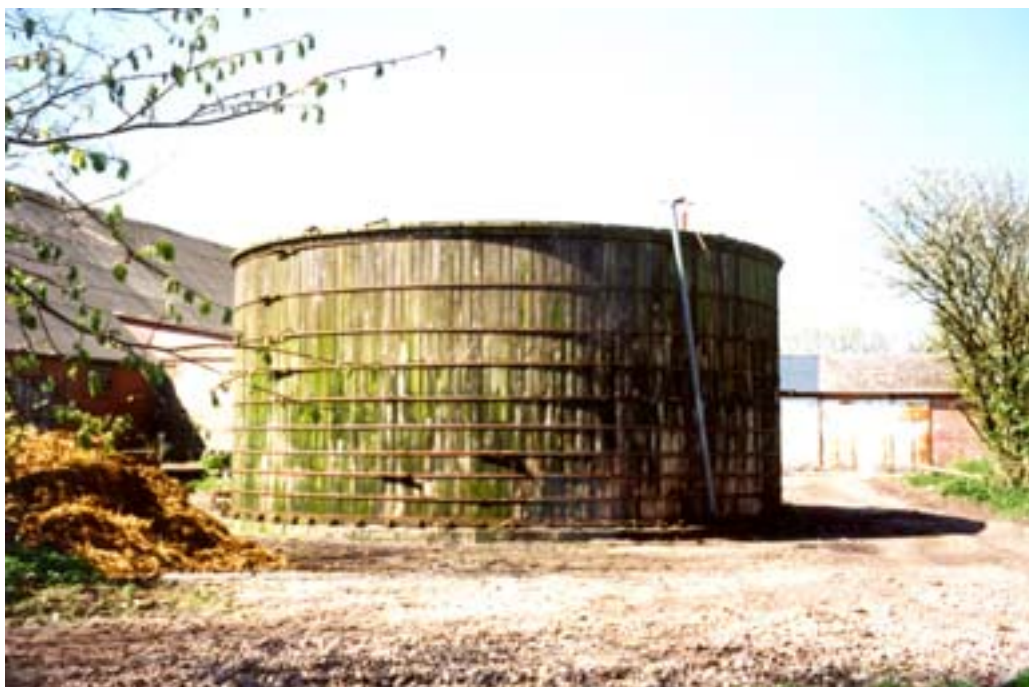
Figur 6.1 En beholder af træ. Den består af lodrette imprægnerede træstave sammenholdt med spændebånd. Bundplade af beton er i terrænniveau.
