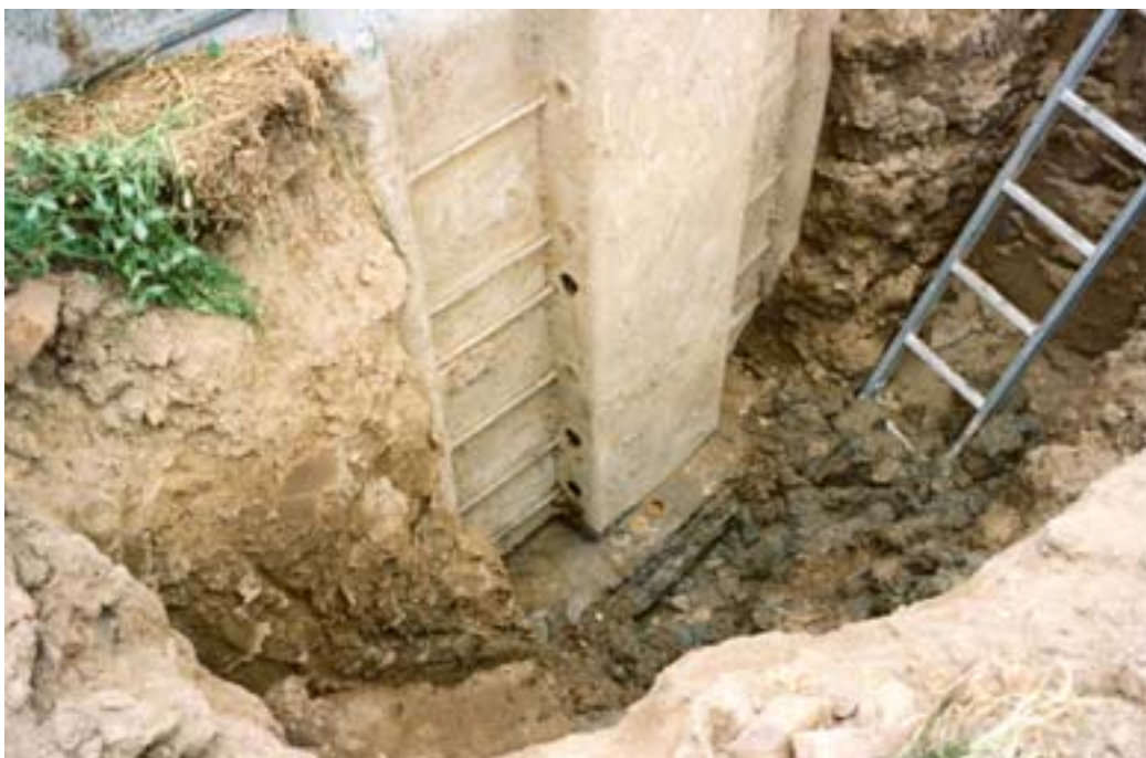
Figur 7.1 Opgravning skal ske til niveau med bund. Ved beholdere med låseelement for kabler foretages opgravningen som her, så såvel kabler som låse kan kontrolleres.
