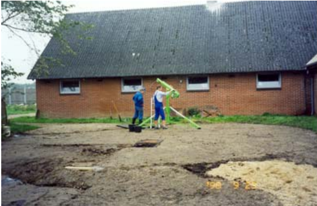
Figur 7.9 Ved indvendig kontrol af lukkede gyllebeholdere skal der være hjælpere, sikkerhedsline og iltforsyning.
