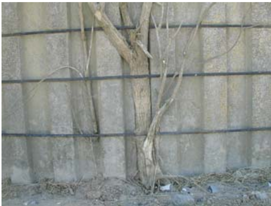
Figur 7.16 Møn tank med udvendige kabler. Træet er nu fjernet.
