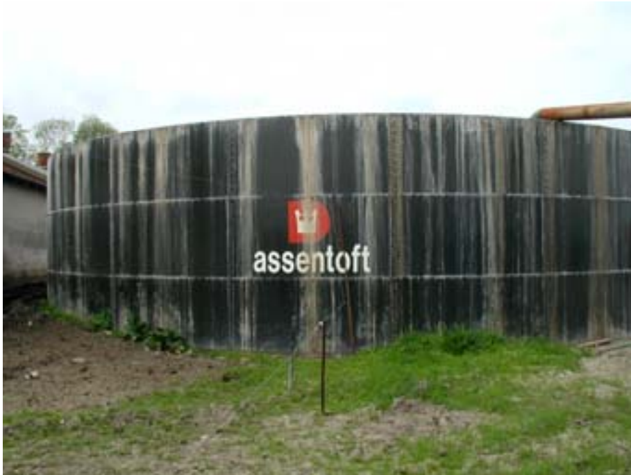
Figur 5.1 Stålbeholder med væg af glatte profiler. Beholderen har fundament i terrænniveau.
