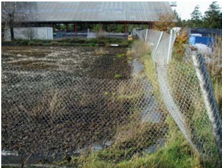
Figur 6.5 Lagune af plastmembran. Sådanne laguner uden overdækning er opført i perioden 1975 til 1985. Der er i dag kun få i anvendelse, da holdbarheden ikke særlig lang.
