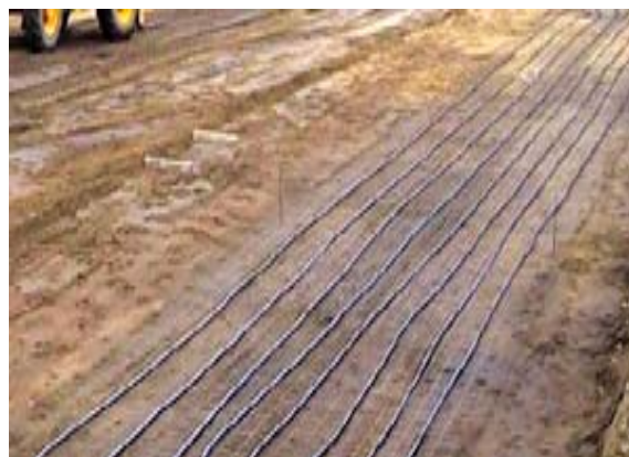
Figur 2: Eksempel på placering af køleslanger i bunden af en kommende gyllekanal.
